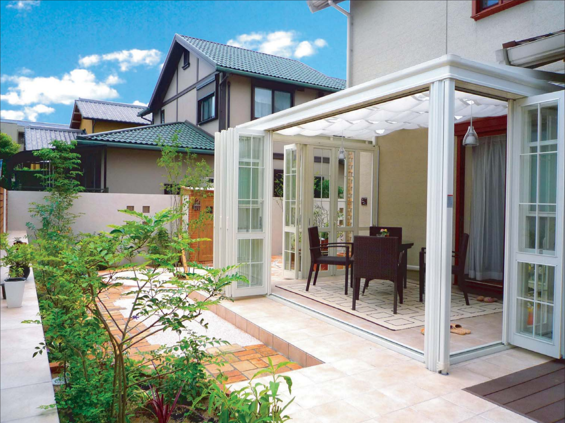
▲当社設計施工お客様邸（施工後）
